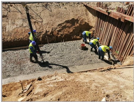
A sajtolási erők felvételére és a sajtoló gép fogadására beton szerkezetek épültek
