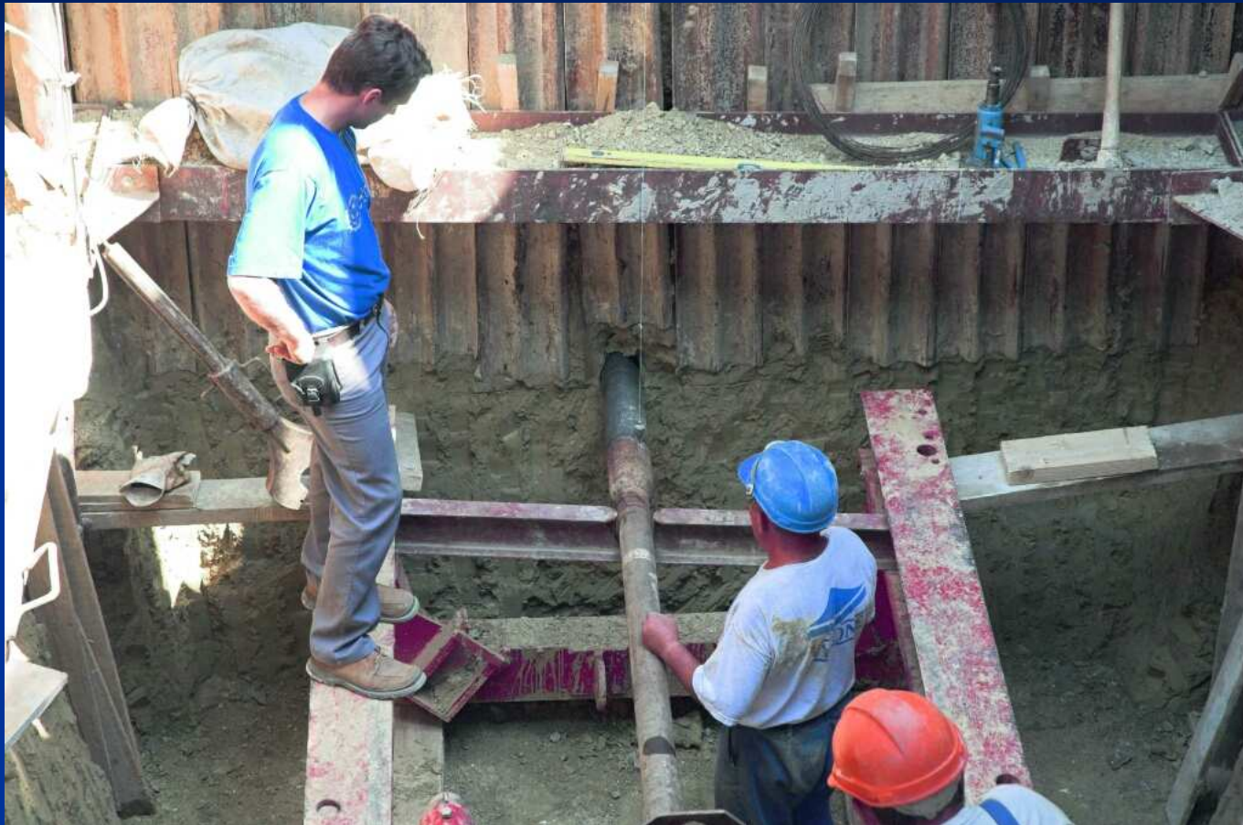
AZ IRÁNYÍTÓFEJET BESAJTOLJÁK A TALAJBA
