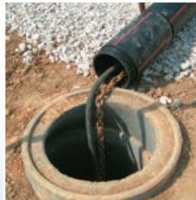
Csőbefűzés az 1000 mm átmérőjű tisztító aknába (roppantóakna)
