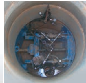
Húzógép az 1000 mm átmérőjű tisztító aknában (húzóakna)
